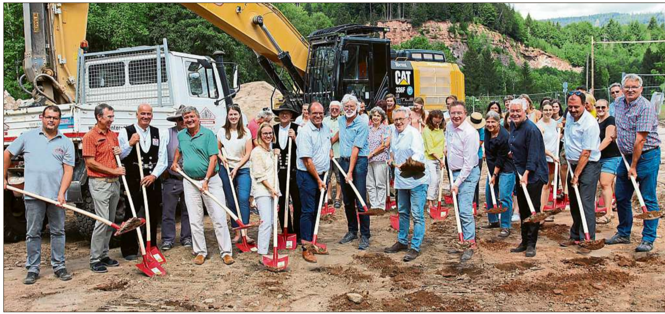
Den Spatenstich für den Bau des neuen Schulhauses in Heselbach vollzog das Mitarbeiterteam des Osterhofs um Leiter Martin Schmid mit Bürgermeister, Behörden- und Firmenvertretern sowie Architekten und Fachplanern. Foto: Sannert
